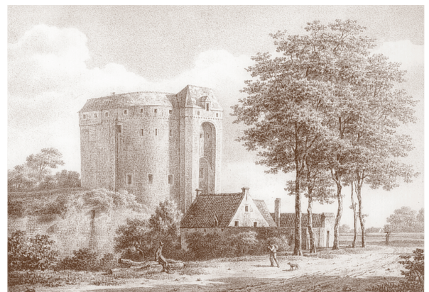
La porte de Hal depuis la campagne extérieure. Vers 1786.
